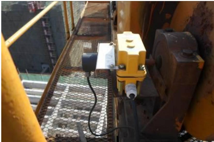
(3) 将传感器的信号线通过塔机上原先的走线方式连接到控制箱内。
